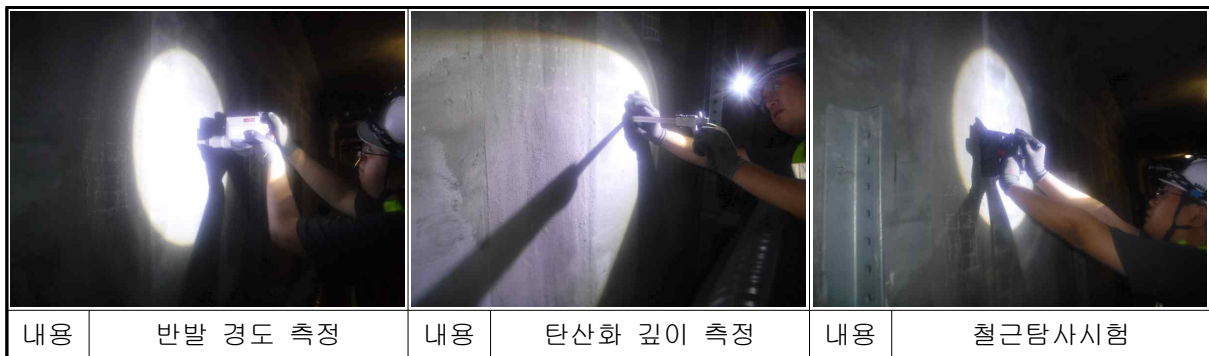
【사진 3.4】 신가평-미금 전력구 재료시험 전경
